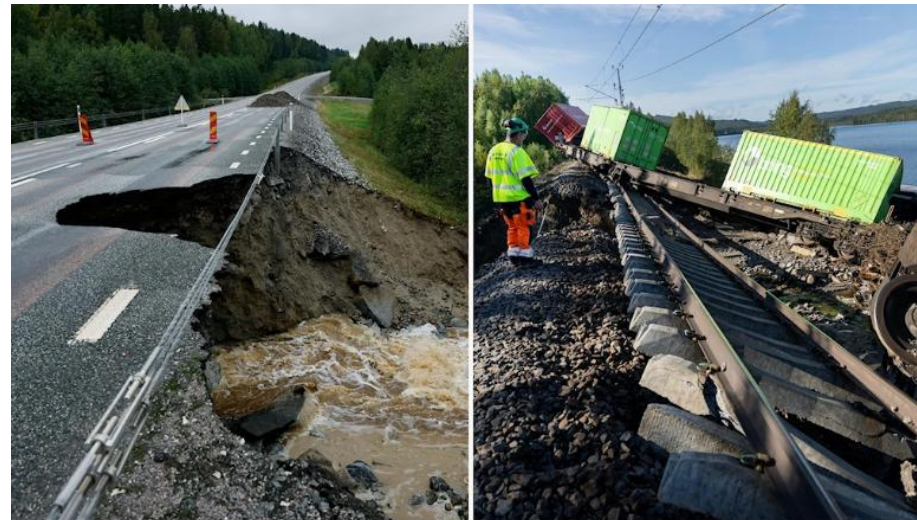
Till vänster: Väg 90 mellan Bollstabruk och Sollefteå har rasat. Till höger: Tåg som spårat ur. Foto: Mats Andersson / TT
